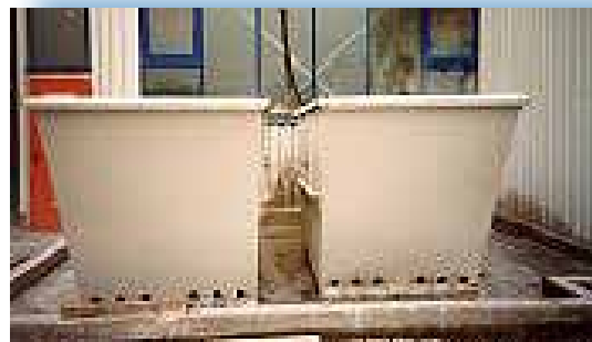
Tehokas ratkaisu betonituotetehtaalla. Kahden vaihtoehtoisen ECON-säiliön käyttö mahdollistaa lisälietteen tiivistämisen.
